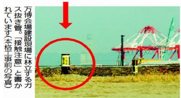
万博会場建設現場に林立するガス抜き管。「接触注意」と書かれています（本格工事前の写真）
